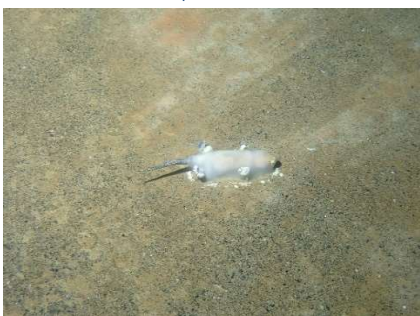
腐食による脱落
