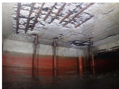
鉄筋の錆膨張による崩落
