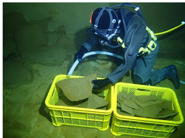
モルタル・コンクリート殻の除去
