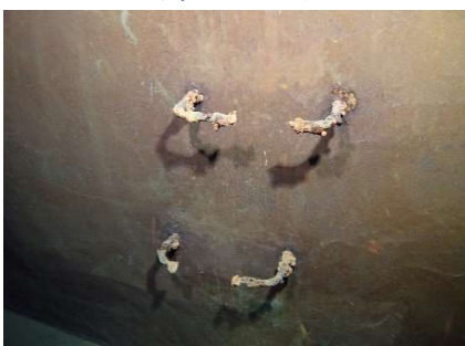
腐食による脱落
